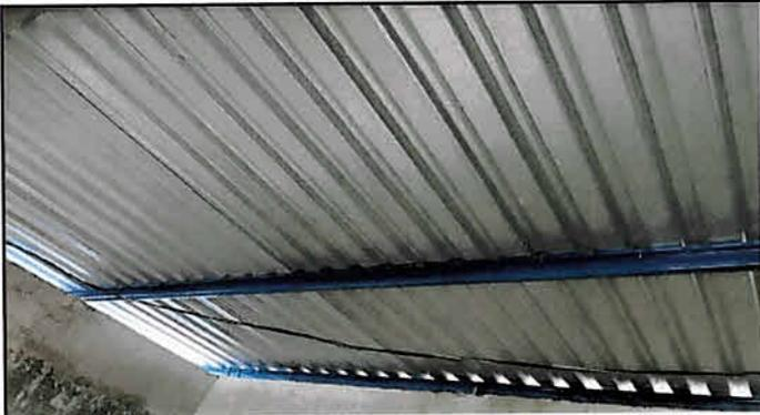
Foto1: sustitucion de lamina por lamina calibre 26
